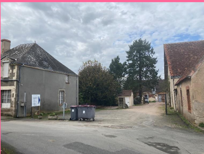
Figure 7 : vue du "Panier de Célestine" en retrait de l'alignement des autres bâtiments.
