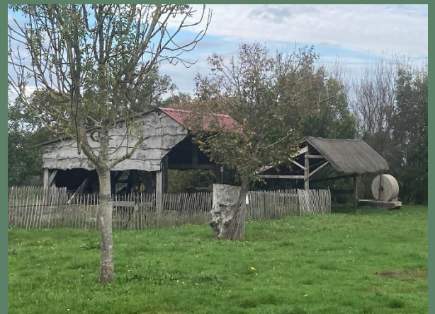
Figure 14 : vue de la scierie
