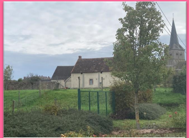
Figure 6 : vue de la façade arrière du "Panier de Célestine".
